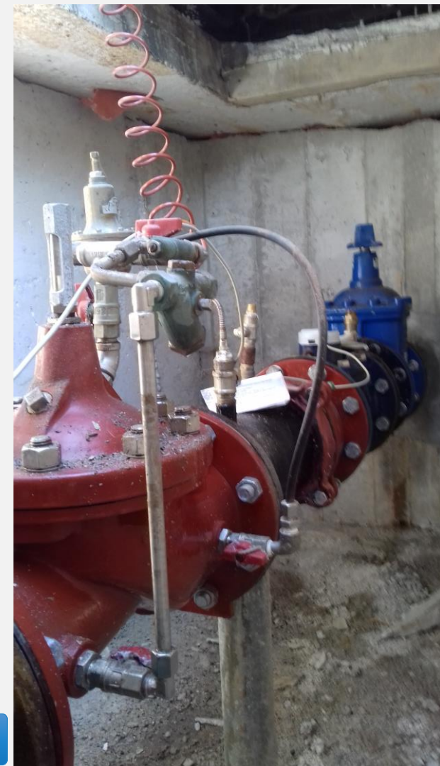
Βαλβίδα μείωσης πίεσης PRV
